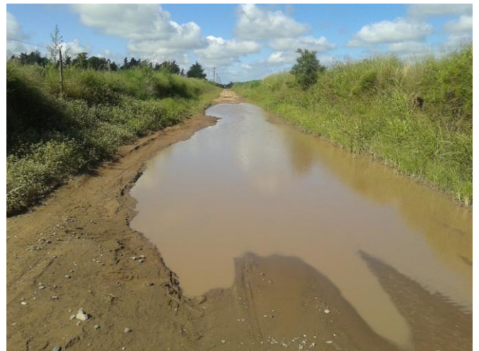
Foto 4: Camino rural afectado por el exceso de agua escurrida y/o precipitada.
